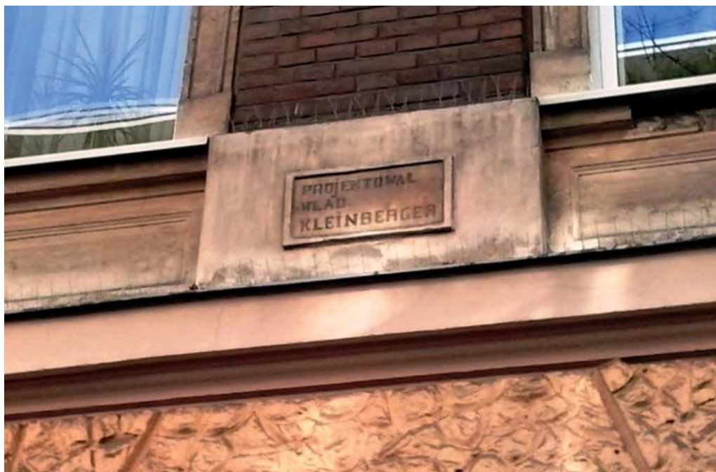
Fot. 15. Kamienica ul. Rakowicka 3, proj. Władysław Kleinberger, budowa 1899-1900.
