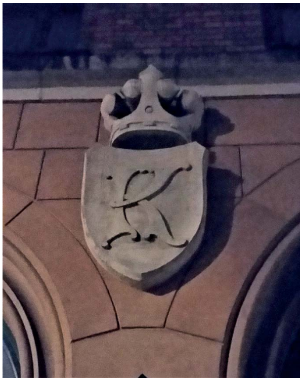
Fot. 166. Szkoła Miejska, ul. Wąska 3/7, proj. Jan Zawiejski, budowa 1905-1910.
