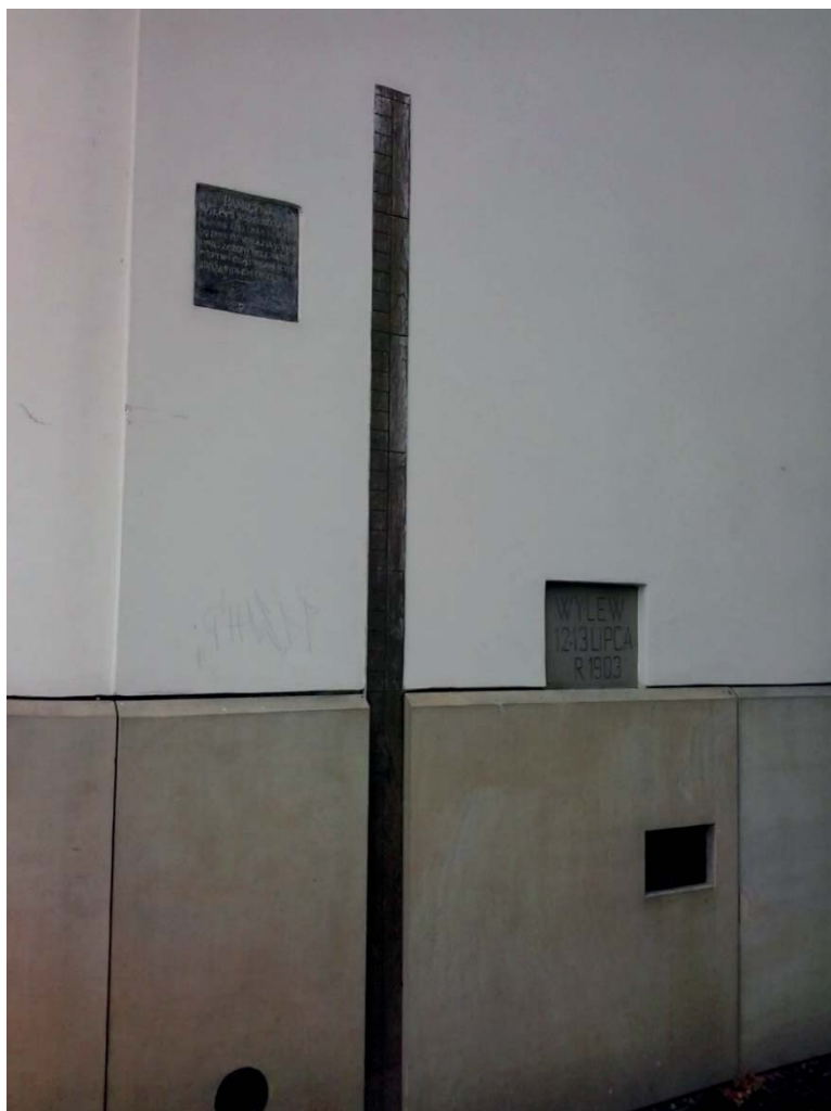
Fot. 164. Znaki wysokiej wody, Plac Na Groblach.
