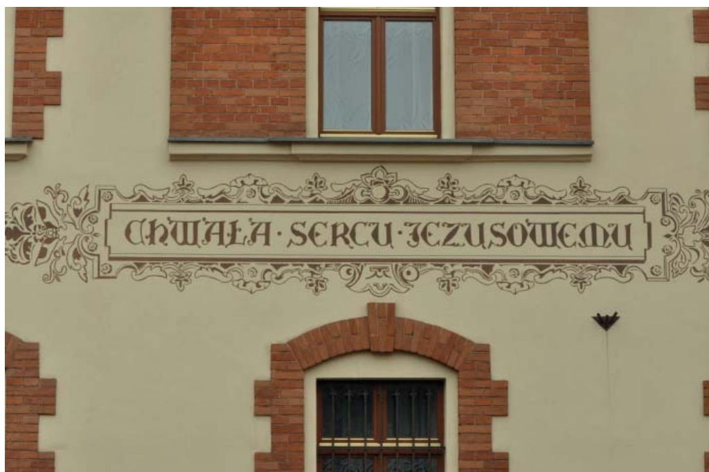
Fot. 135. Dom zgromadzenia Sióstr Sercanek, ul. Garncarska 24-26, proj. Władysław Kaczmarski, budowa 1895-1896.
