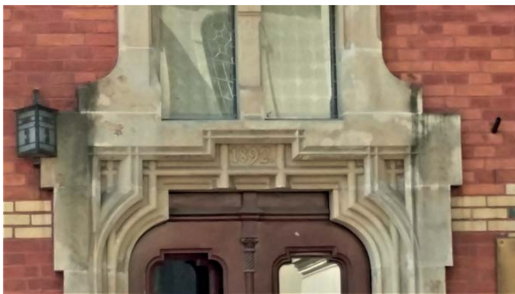
Fot. 94. Kamienica ul. Kurniki 3, proj. Jan Sas-Zubrzycki, Józef Donheiser, budowa 1892-1893.
