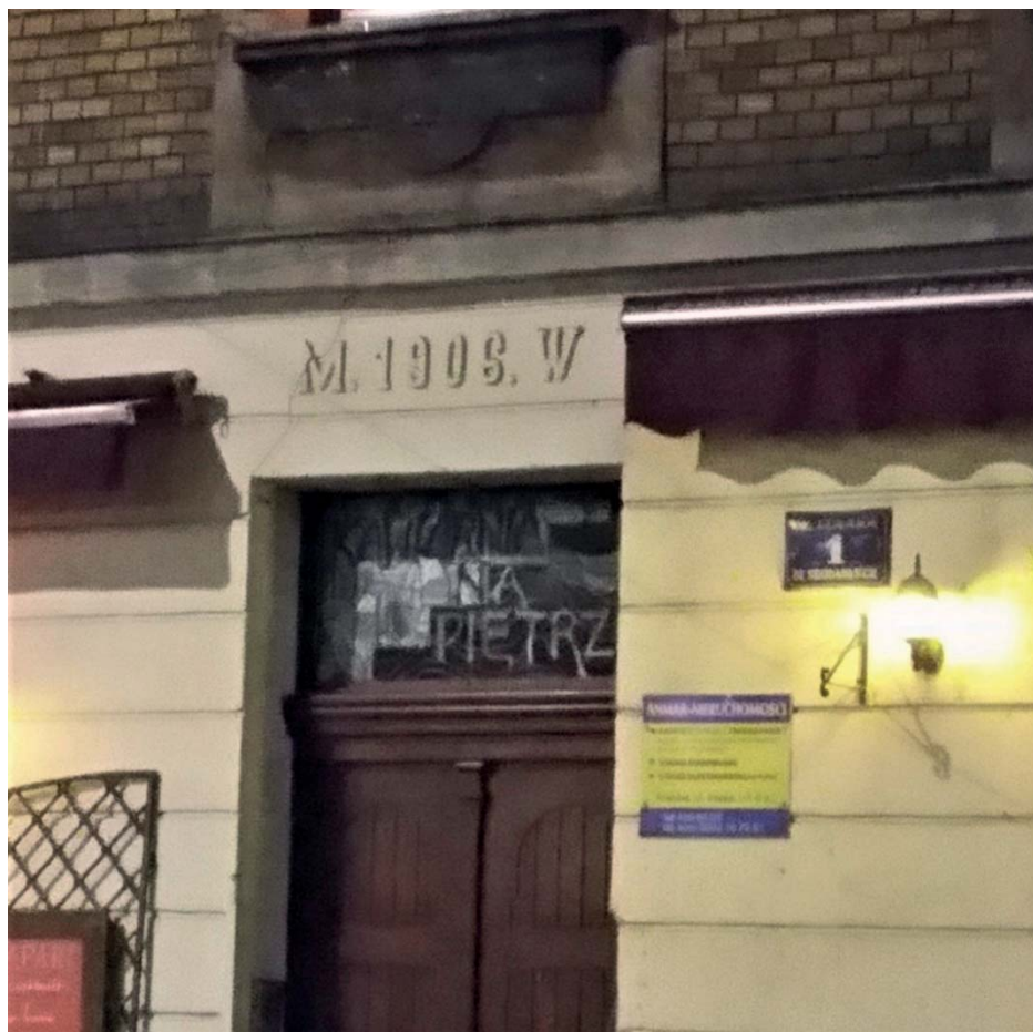
Fot. 113. ul. Izaaka 1/ ul. Estery 20, proj. nieznaný, budowa 1906.
