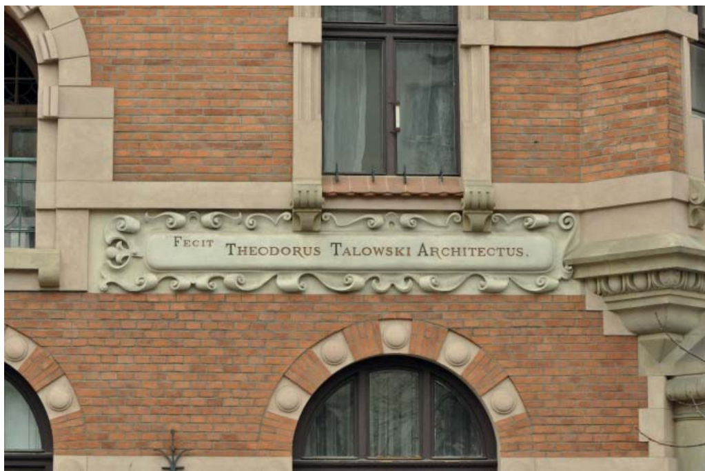
Fot. 69. Podpis architekta – detal kamienicy ul. Retoryka 9.
