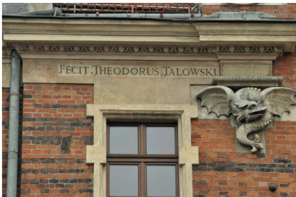
Fot. 19. Kamienica ul. Karmelicka 35, proj. Teodor Talowski, budowa 1889.
