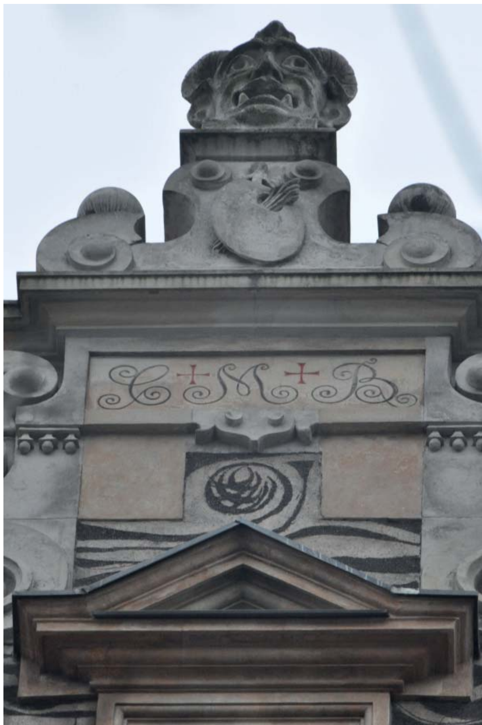
Fot. 82. Kamienica ul. Smoleńsk 20, proj. Teodor Talowski, budowa 1888-1889.
