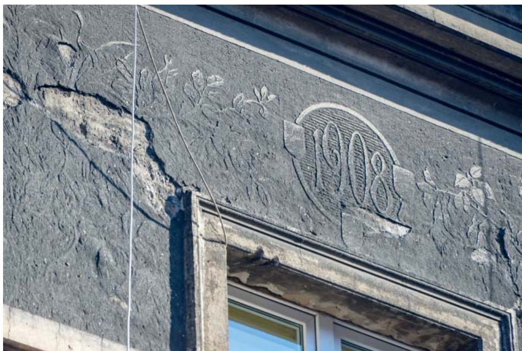
Fot. 51. Data, ul. Konarskiego 17.
