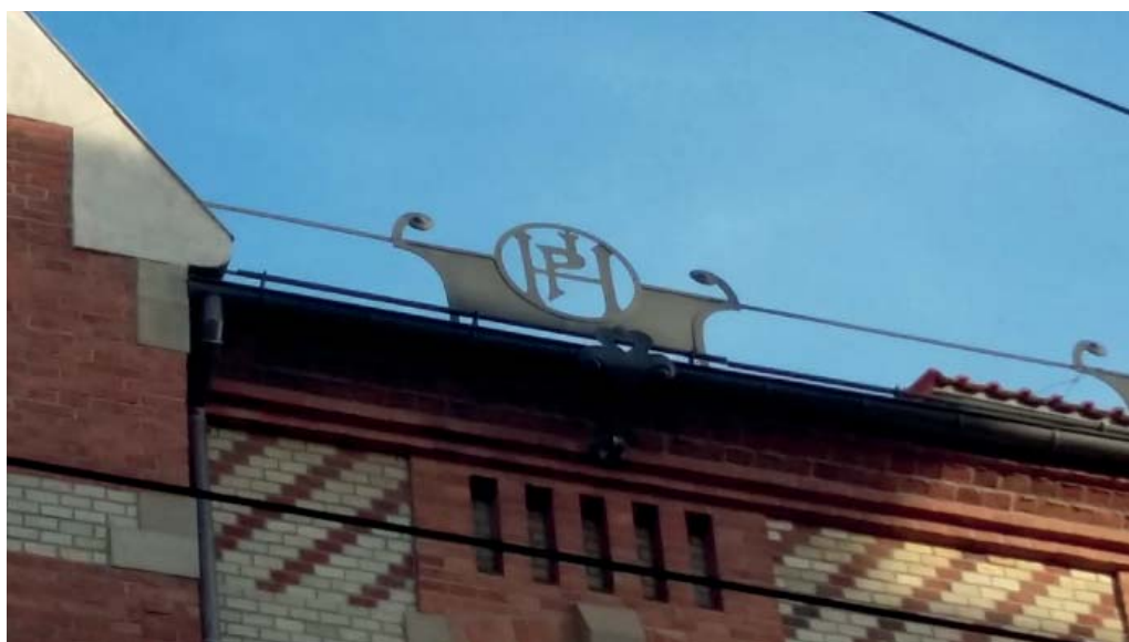
Fot. 144. Dom „pod Globusem”, ul. Długiej 1/ ul. Basztowa 11, proj. Franciszek Mączyński, Tadeusz Stryjeński, lata budowy 1904-1906.
