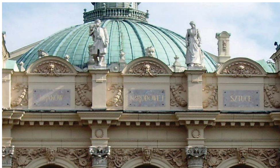
Fot. 133. Teatr Miejski, proj. Jan Zawiejski, budowa 189-1893.
