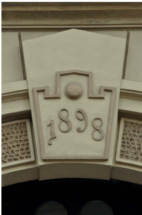
Fot. 93. Kamienica ul. Św. Filipa 25, proj. Jan Sas-Zubrzycki, budowa 1898.
