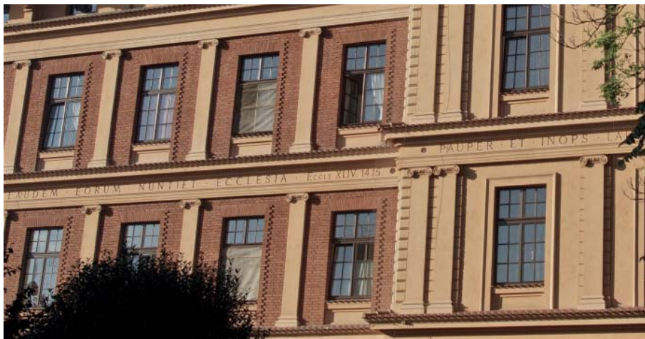
Fot. 121. Dom Ubogich Fundacji im. A. i L. Helclów.
