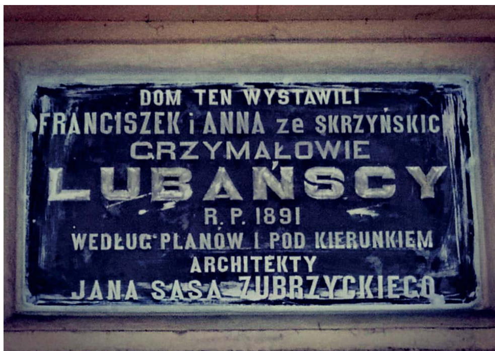
Fot. 155. Kamienica ul. Rakowicka 21, proj. Jan Sas-Zubrzycki, budowa 1891.
