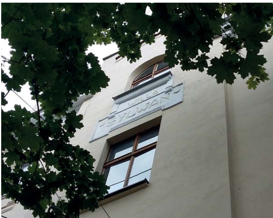
Fot. 149. „Willa Sylwan”, ul. Barska 8/ ul. Powroźnicza 6, proj. Beniamin Torbe, budowa 1912.
