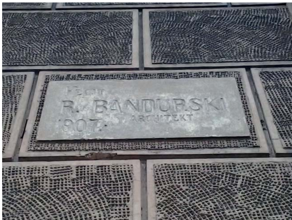
Fot. 35. Dom własny architekta, ul. Barska 30, proj. Roman Bandurski, budowa 1907-1911.
