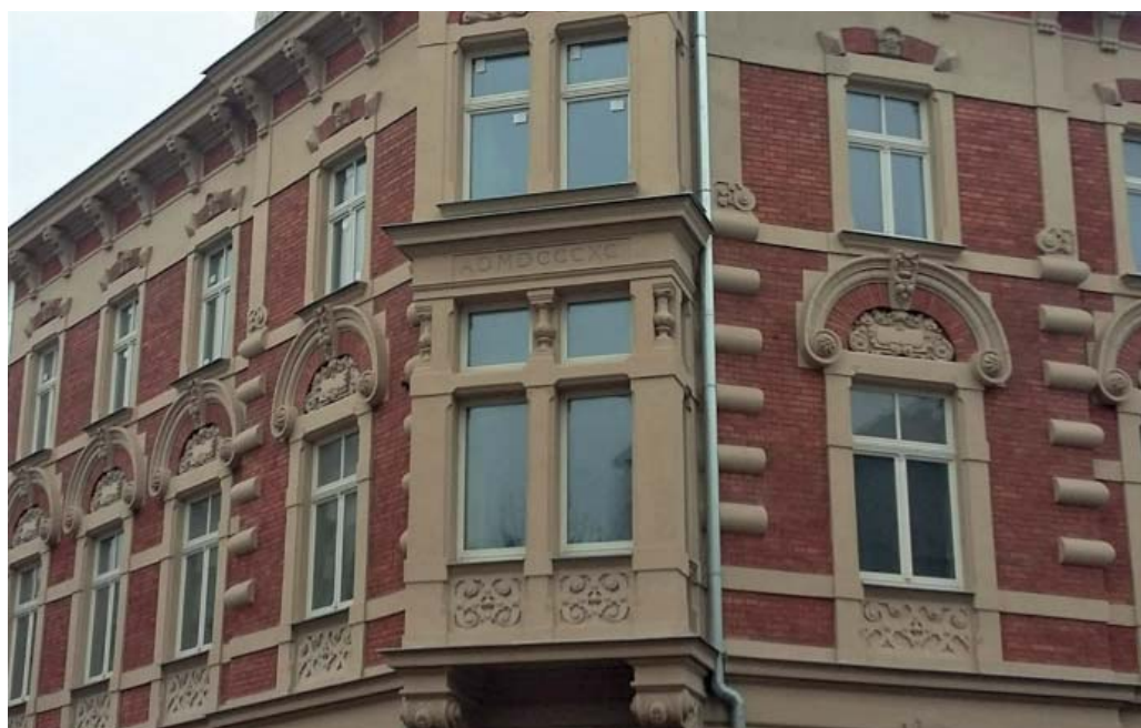
Fot. 108. ul. Siemiradzkiego 2, proj. Jan Zawiejski, budowa 1889-1890.
