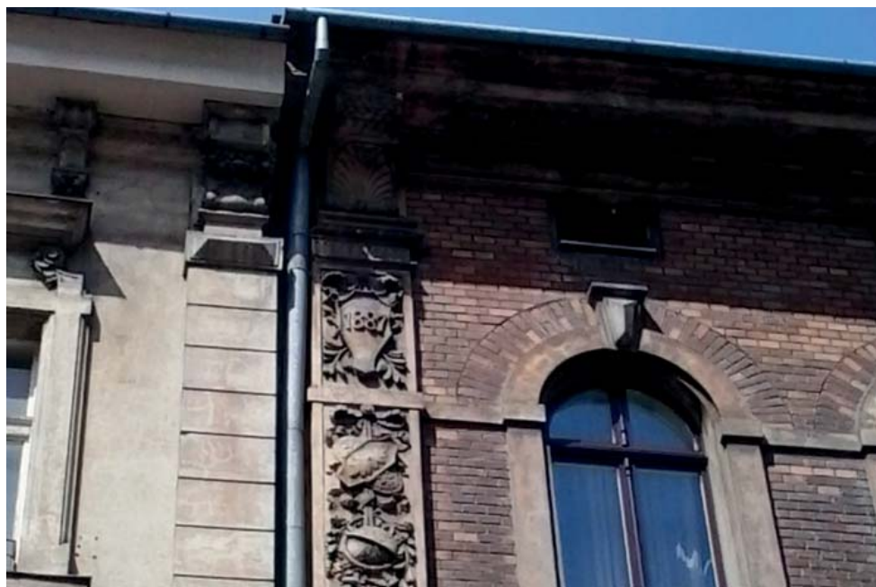
Fot. 91. Kamienica ul. Studencka 23, proj. Sławomir Odrzywolski, budowa 1886-1887.
