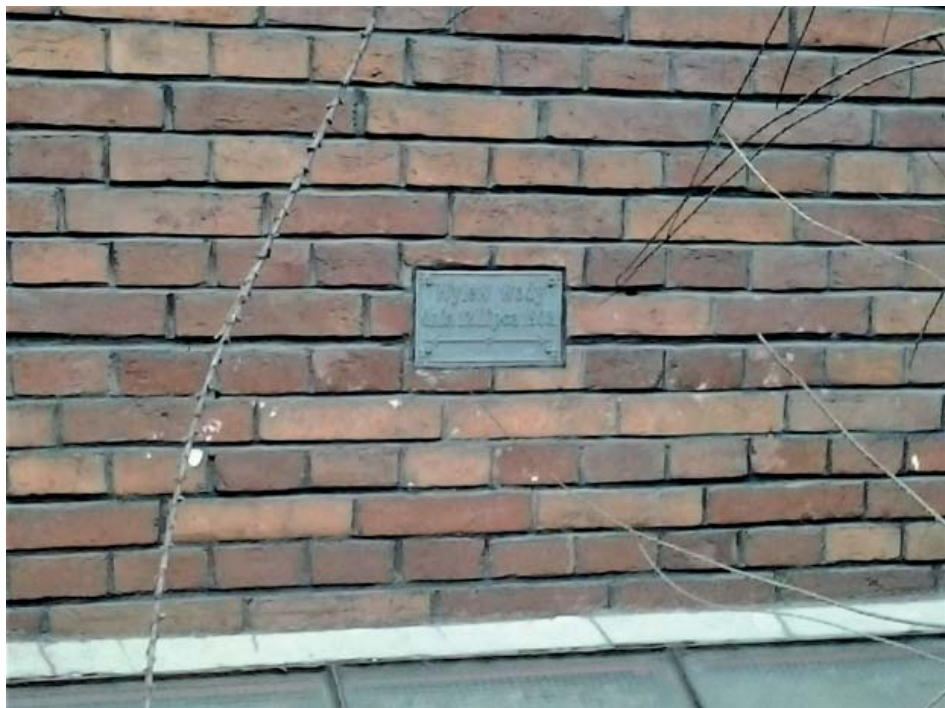
Fot. 161. Znak wysokiej wody, budynek Sokoła, ul. Piłsudskiego 27.
