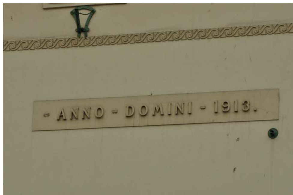
Fot. 97. Podstacja elektryczna pl. Biskupi 1, proj. Jan Rzymkowski, budowa 1908-1913.
