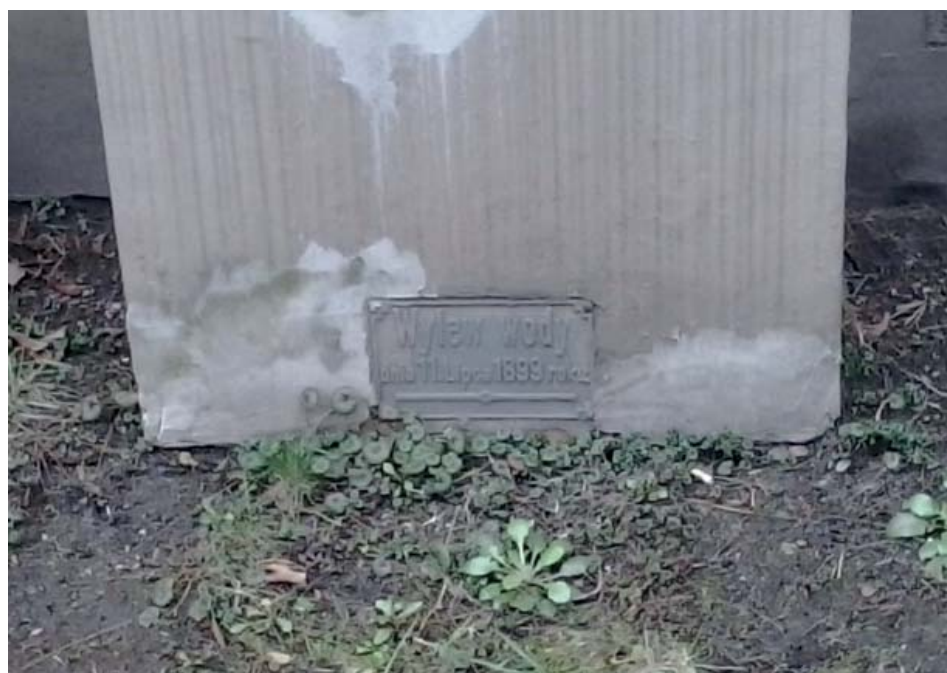
Fot. 160. Znak wysokiej wody, budynek Sokoła, ul. Piłsudskiego 27.
