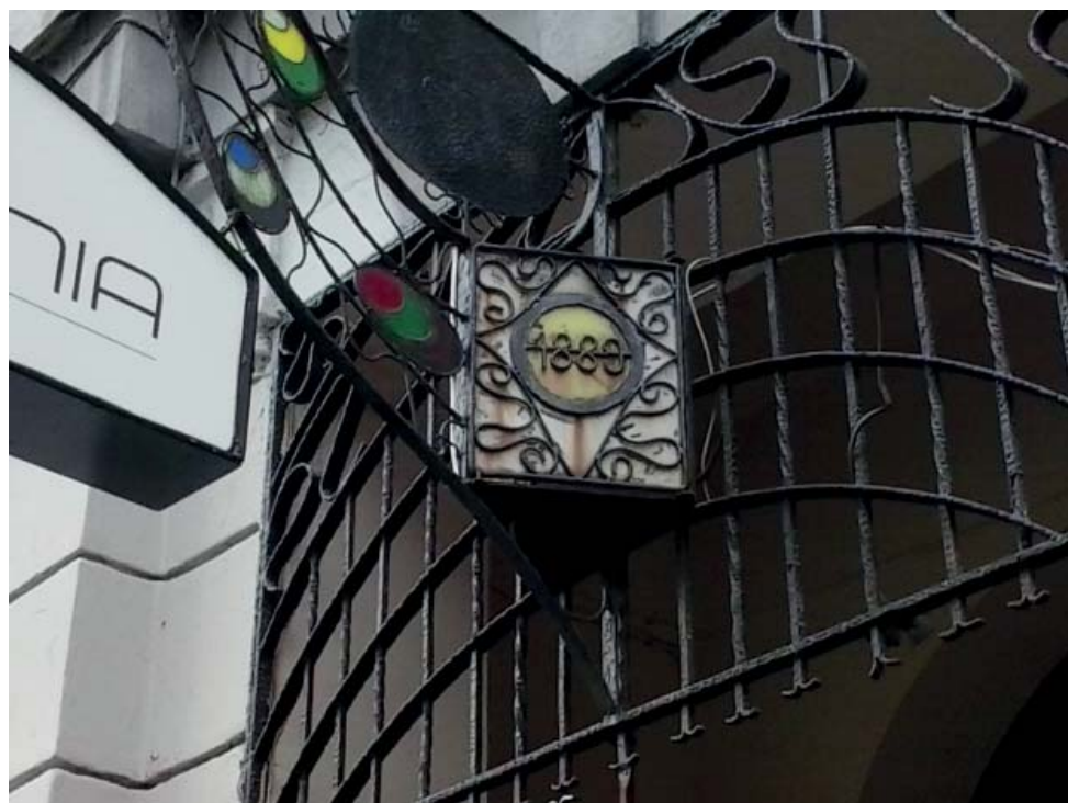
Fot. 107. Detal kamienicy ul. Starowiślna 12, proj. nieznan, budowa 1889.
