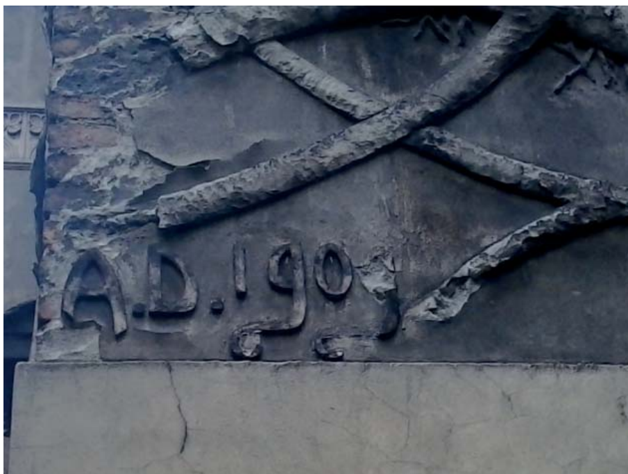
Fot. 116. Willa ul. Barska 24, proj. Roman Bandurski, budowa 1909.
